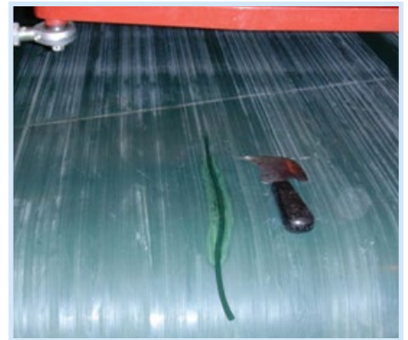
Banda FRPZ-8 reparada con electrodo
